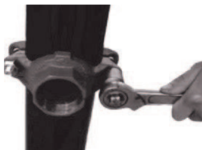
5. Dokręcanie śrub
