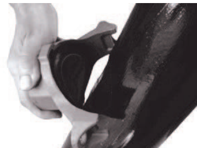
3. Instalacja uszczelki
